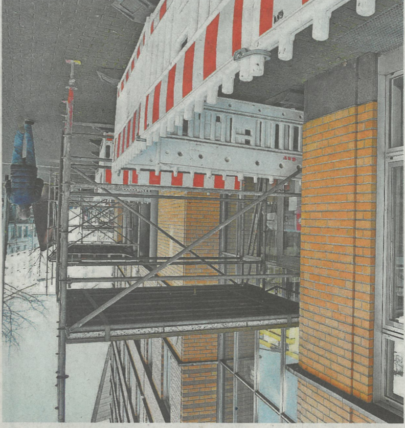
Diese Aufnahme zeigt die Vorsichtsmaßnahmen entlang der Fassade des großen Agentur-Gebäudes in der Hafenstraße.
